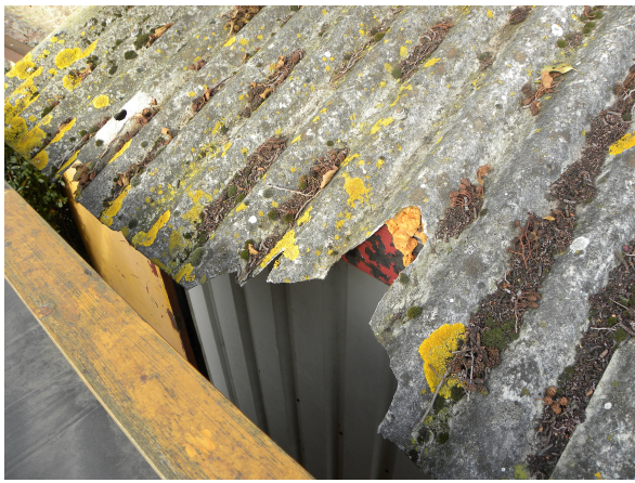
Afbrokkelend asbestdak
